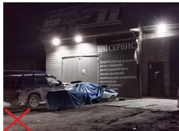
Недопустимо устанавливать светильники (прожекторы) со слепящим эффектом.
