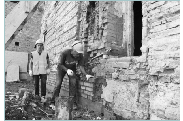
проектов является оптимизация системы теплоснабжения города Енисейска.
